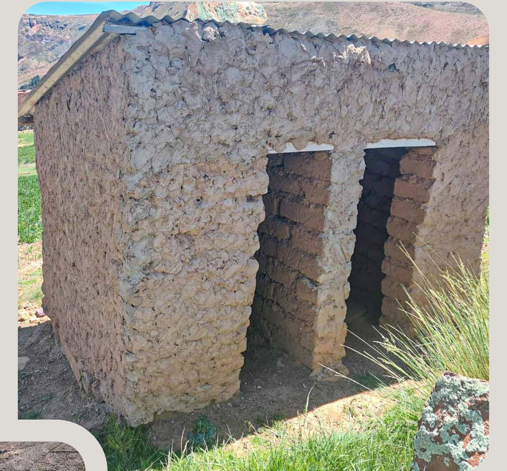
Aktueller Zustand der Sanitäranlagen
